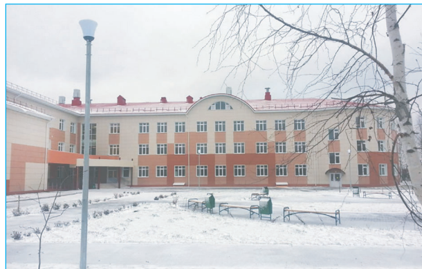
Сегодня на её месте построена современная школа на 300 мест с бассейном и спортплощадкой.
